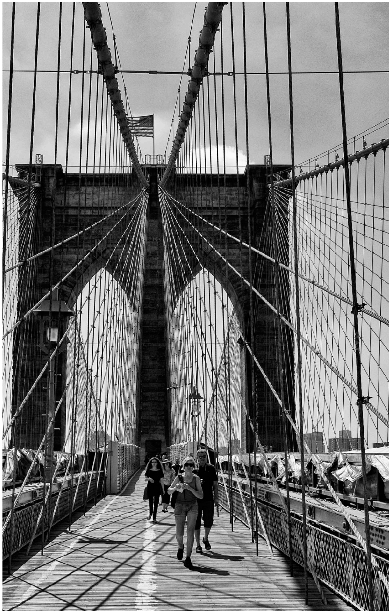
När man kommer upp på bron ser man tydligt att det är en hängbro. Alla vajrar bildar ett fint mönster och är ett känt motiv för fotografer.
