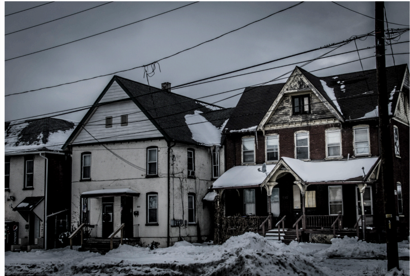
Williamsport, USA. Fastighet vid West 3rd street med renoveringsbehov.
